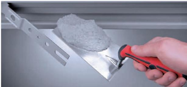
En cas de fixation par les pattes de fixation, il est conseillé de créer des entailles dans le support (section 80 x 200 mm). Les pattes de fixation doivent être pliées et bloquées dans le mur. Pour une bonne résistance au feu et une bonne tenue mécanique, le vide entre dormant et mur doit être rempli de ciment mortier.
